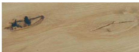
Дефект на необработанной паркетной доске
